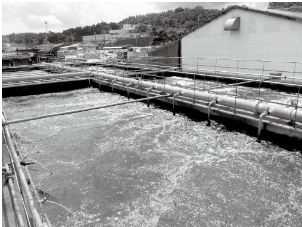
活性汚泥による排水処理装置の例
