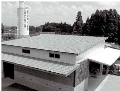
シラス洋瓦の施工例（当社工場）
