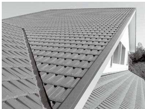
シラス大判瓦の施工例
