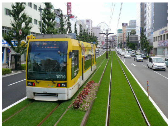
シラス緑化基盤による軌道敷緑化
