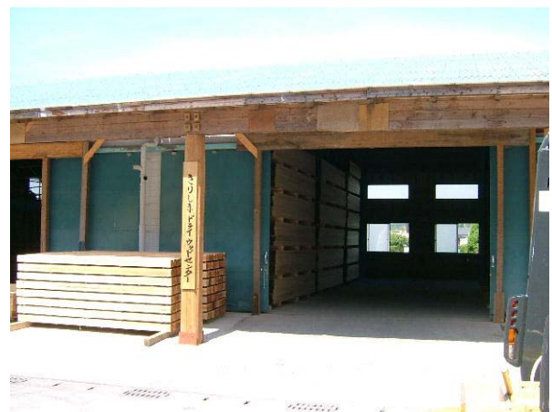
きりしまドライウッドセンター
