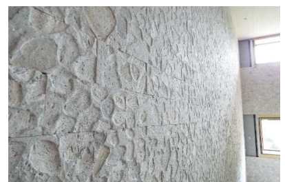
施工例；内装(象がんタイル)
