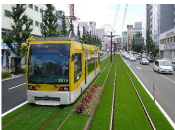
施工例；軌道敷(緑化基盤)
