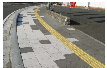
施工例；歩道(多層平板)
