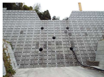
施工例；砂防ダム(緑化基盤)
