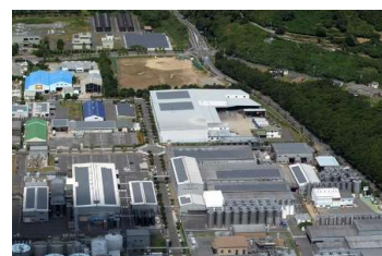
太陽光パネルを設置
